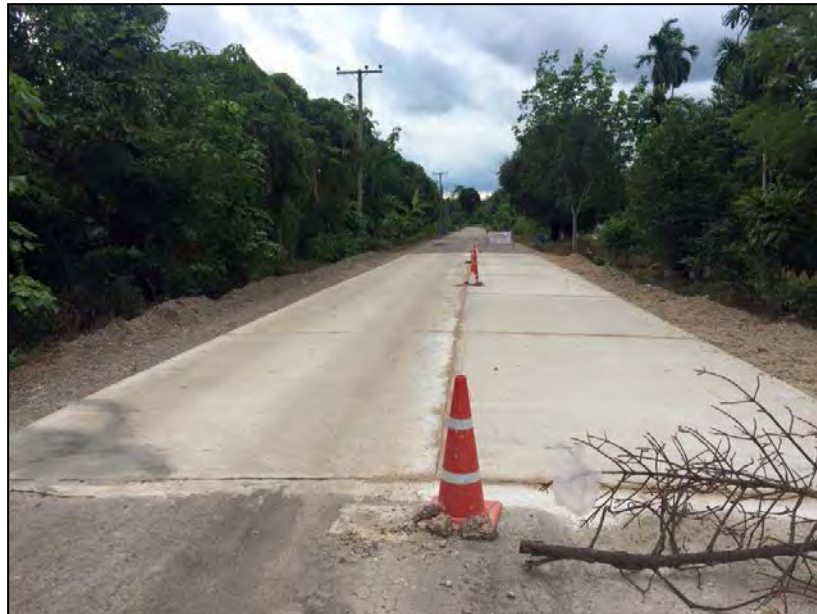
ภาพถ่ายปรับปรุงถนนคอนกรีตเสริมเหล็ก สายสามแยกประแส - เขาจุก - น้ำเป็น หมู่ที่ 8
