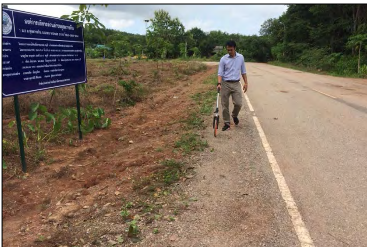
ภาพถ่ายโครงการงานวางท่อน้ำดิบ หมู่ที่ 9
