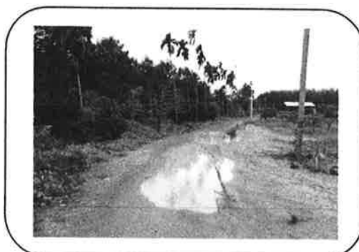
๔๔. ปรับปรุงถนนโดยการลงหินคลุก ซอยริมคลอง หมู่ที่ ๑๑
